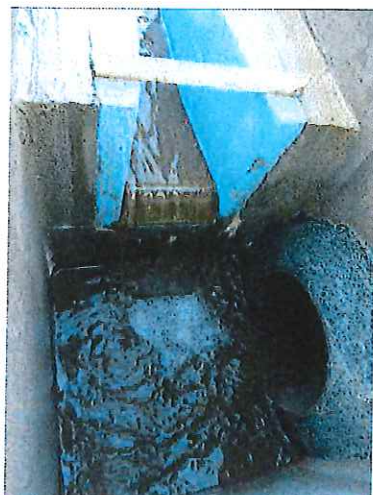
Point de prélèvement en aval du canal de comptage.
