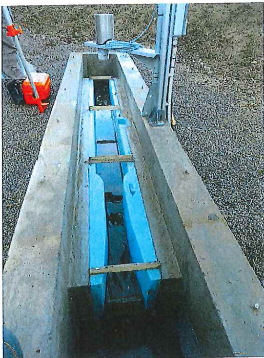
Vue d'ensemble du canal.
